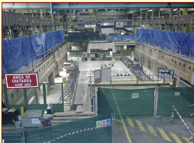
Planta de Prensas - Construcción de una nueva línea de Prensas
