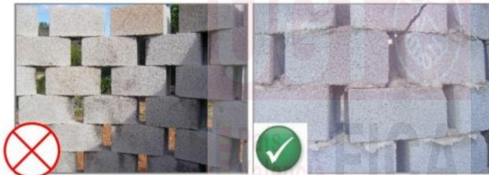
Imatge 4.- Construcció formada per blocs amb i sense ciment d'unió. Font: Normes Tècniques de Cremadors Agrícoles (PPIFDA).
