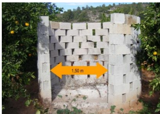
Imatge 2.- Obertura lateral o boca d'alimentació d'un cremador agrícola. Font: Normes Tècniques de Cremadors Agrícoles (PPIFDA).
